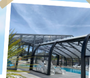
Piscine couverte et chauffée
